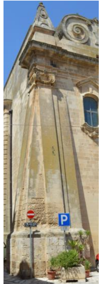
Montescaglios: Chiesa Madre. Contrafforte realizzato sullo spigolo sud ovest della chiesa in base al progetto del 1857 redatto dall'ing. Carelli.
